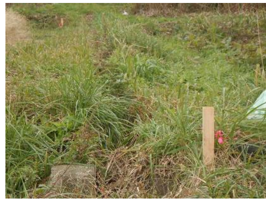
測量の跡（角材が打ち込まれている）が残る米軍基地建設予定地
